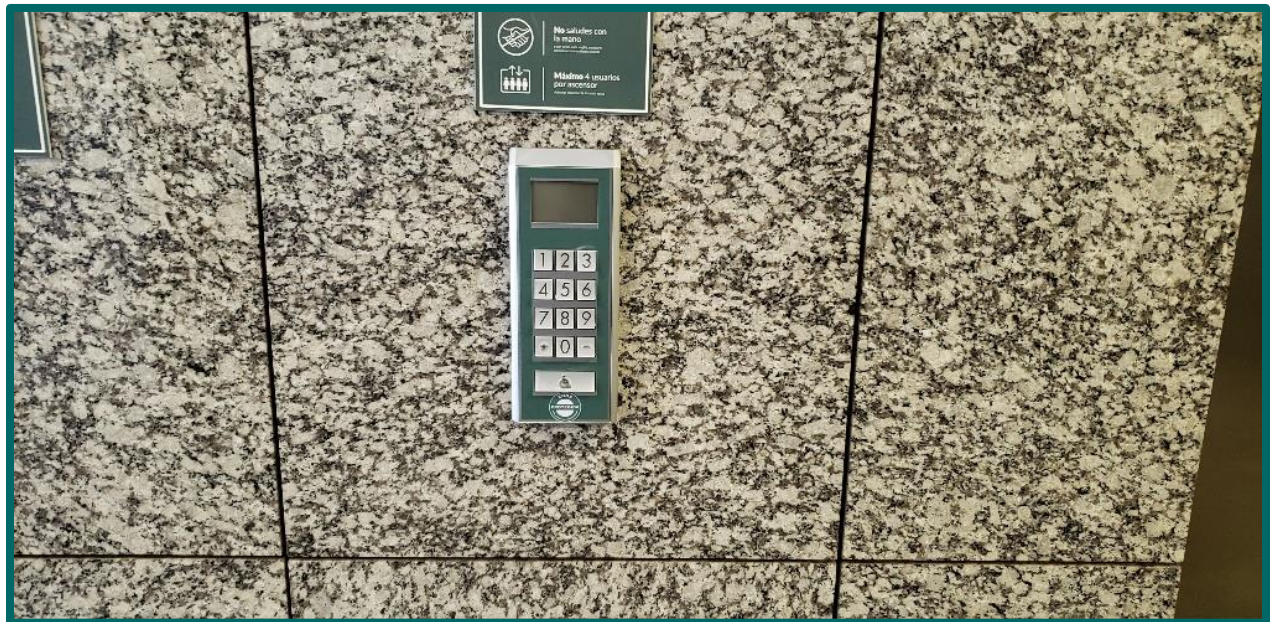
BOTONERAS Y PASAMANOS DE ASCENSORES
